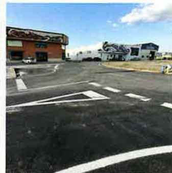
Asfaltado rotonda y tramo acceso al Polígono Industrial
